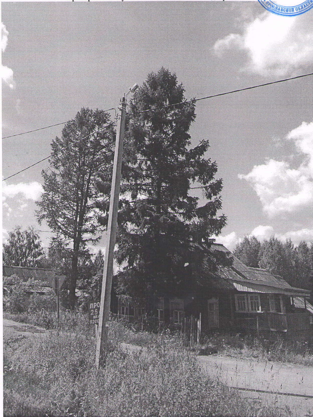
Выполняемые работы: Приобретение и установка светильников.
