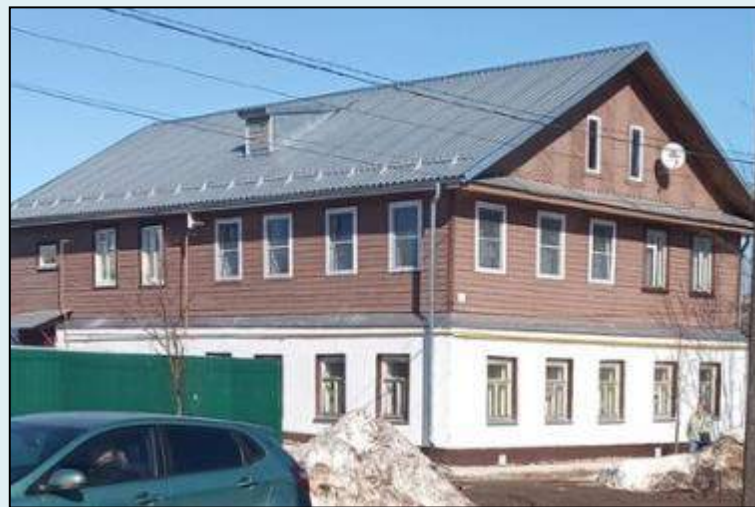
ул. К. Либкнехта, д.39
