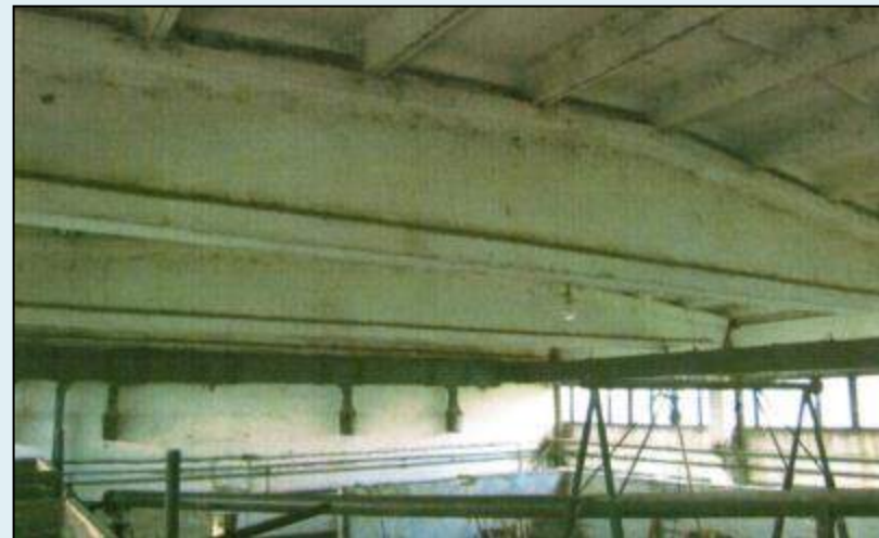
Здание биофильтров, состояние изнутри
